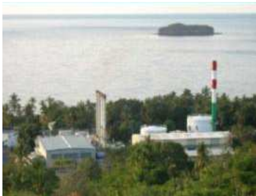
Centrale des Badamiers
